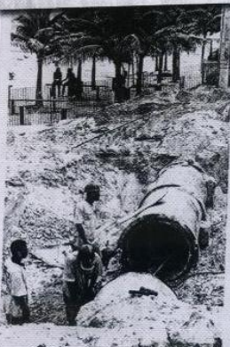
Operários reformam da rede coletora para aumento de capacidade
